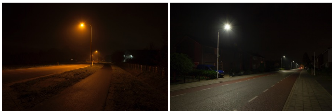
Foto: links een voorbeeld van 'oude verlichting'. Rechts van ledverlichting. De oudere verlichting schijnt alle kanten op en de ledverlichting is gericht licht.
