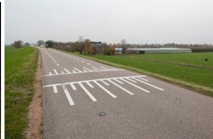
Rechts: lampjes in de weg om drempel aan te duiden.
